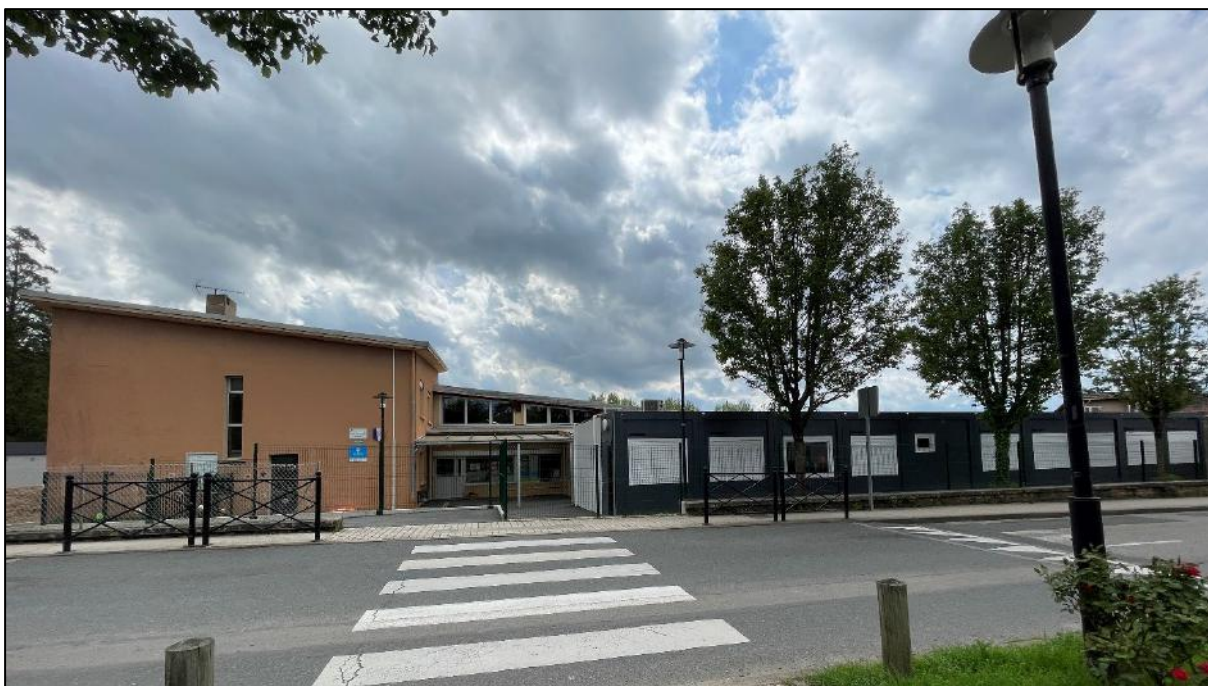
Ecole du Bret avec la présence de bâtiments modulaires à pérenniser
