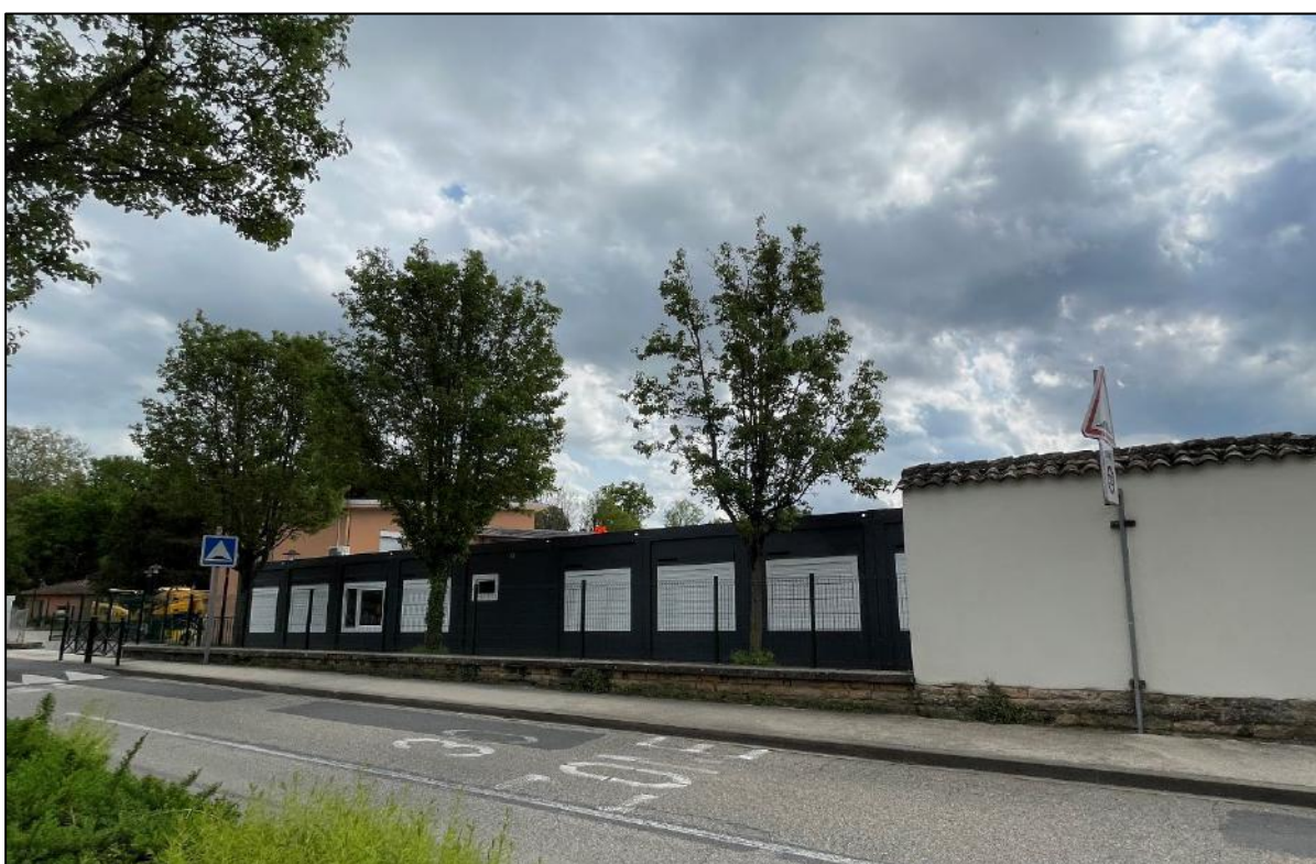
Extension de l'école du Bret par l'installation temporaire de bâtiments modulaires
