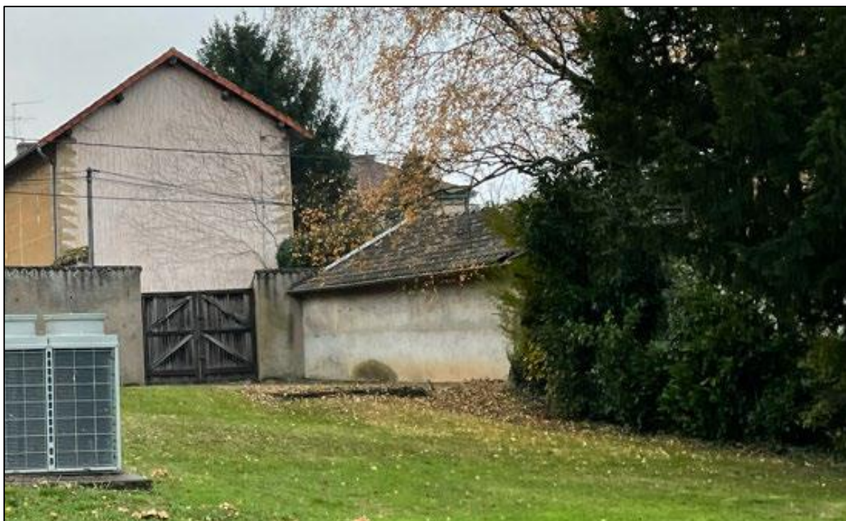
Bâtiment d'habitation à rénover n'appartenant pas au tènement de l'école et de son château
