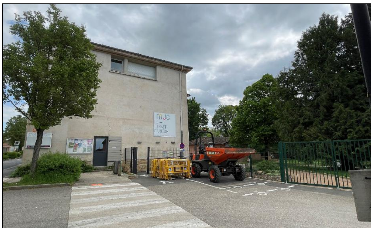
La Maison des Jeunes et de la Culture qui a fait l'objet de travaux réhabilitation et son local annexe
