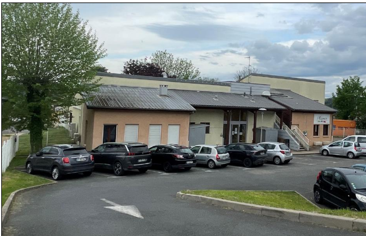
Bâtiment accueillant un centre social et une crèche
