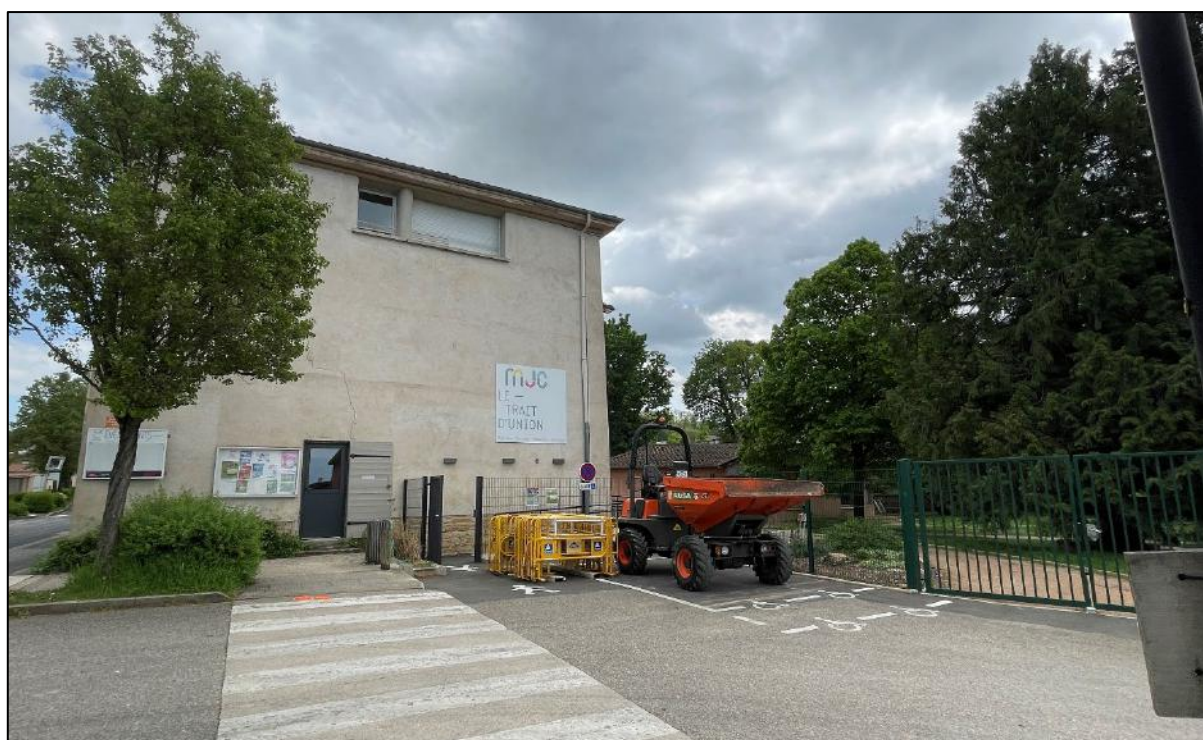
La Maison des Jeunes et de la Culture qui a fait l'objet de travaux réhabilitation et son local annexe
