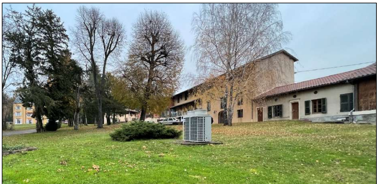
Bâtiments annexes du château
