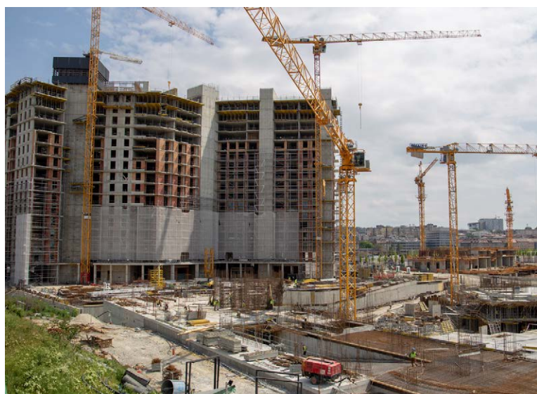
Chantier de construction
