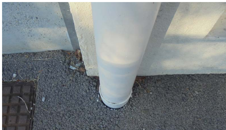
Exemple d'une descente de cheneau hermétique
